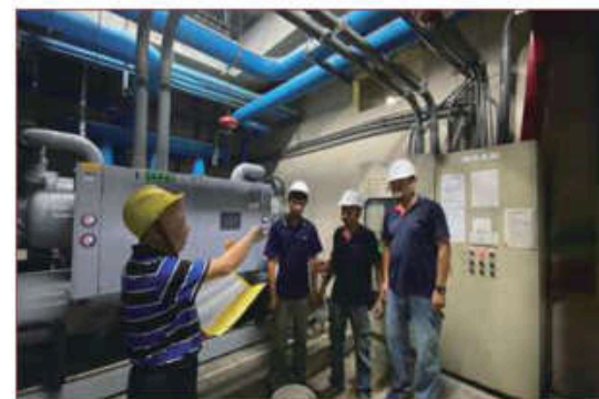
實施冷卻水塔清洗，確實督導承攬商防護具使用及實施承攬商教育訓練。
