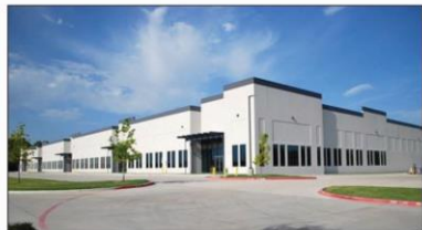
位於East Plano Parkway佔地98,000平方呎的新建廠房。
